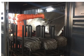
シンガポールTuas港湾工事現場
