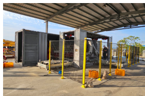
台湾Taoyuan3ターミナル工事現場
